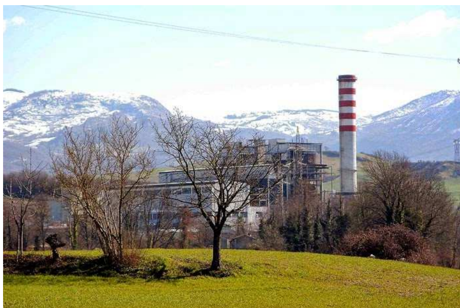
La Centrale del Mercure
